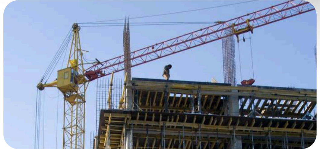
CONSTRUCCIÓN E INFRAESTRUCTURA INDUSTRIAL
